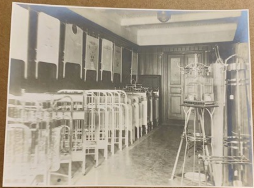
Mezzanino: Riparto mobili di metallo.
